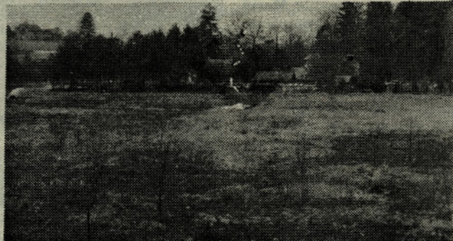
Komunalno odlagališče na Ložnici dobiva novo podobo. Delavci Javnih naprav ga prekrivajo z zemljo.
