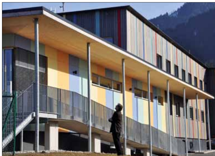
Sklopa vrtca in šole sta ločena po merilu, obdelavi fasade in uporabi barve
