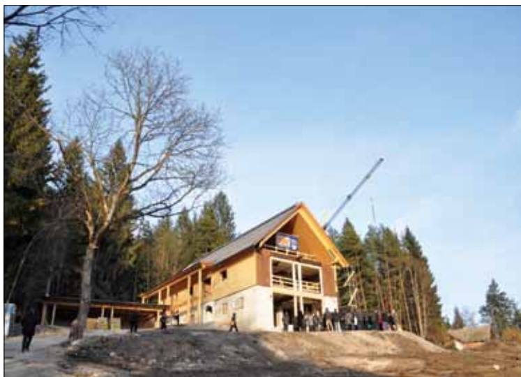
Ogled prenove stare hribovske kmetije, ki bo postala »plus hiša« (arh. Ronacher)
