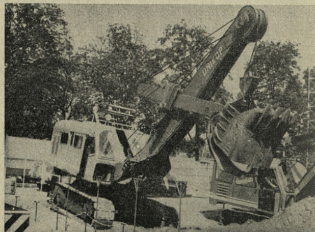
Univerzalna bagra KV-1206 (levo) in KM-503 (desno)
