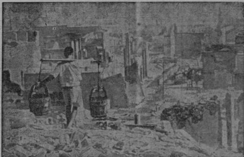
Od japonskih bomb porušeni del Čungkinga, nove Čankajšekove kitajske prestolnice
