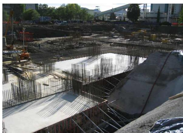
Slika 2.16: Gradnja temeljev glavnega tehničkega objekta šestega bloka v termoelektrarni Šoštanj.
