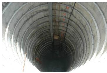
Slika 3.20: Gradnja armiranobetonskega vodnjaka.
