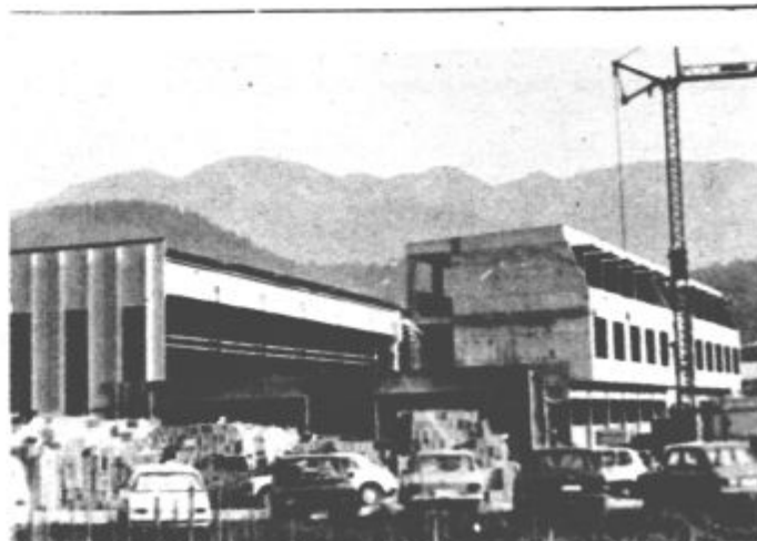
V Nazarjah uspešno dograjujejo nove delovne prostore temeljne organizacije Iverna, v katerih bodo zagotovili oplemenitenje in predelavo ivernih plošč. Obenem bodo zgradili tudi nove upravne prostore in pomembno naložbo izročili namenu ob letošnjem prazniku občine Mozirje, ki ga bodo občani in delovni ljudje Gornje Savinjske doline letos slavili v Nazarjah.
