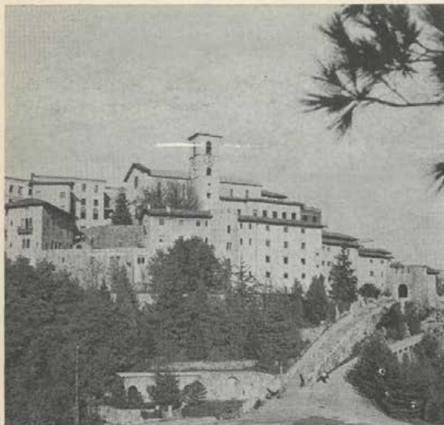
Pogled na Staro goro pri Čedadu
