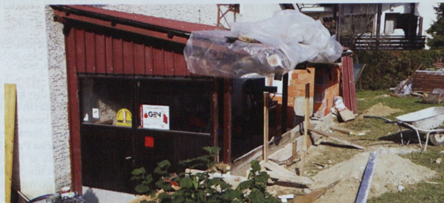
Trenutno prenavljajo delavnico servisa in prodaje gasilnih aparatov.
