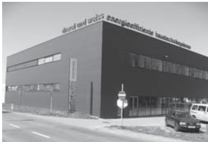
Slika 10: Industrijski objekt podjetja Drexel und Weiss, Wolfurt, Avstrija. Figure 10: Industrial facility of the Drexel & Weiss company, Wolfurt, Austria.
