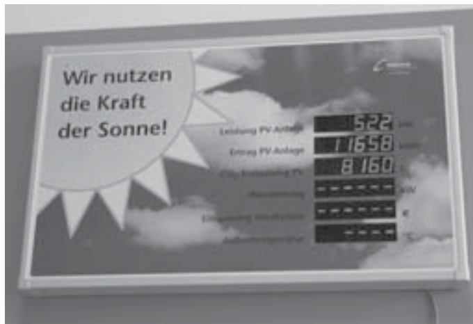
Slika 2: Na steni glavnega hodnika je mogoče ves čas spremljati količino pridobljene električne energije ter prihranek CO 2 .
