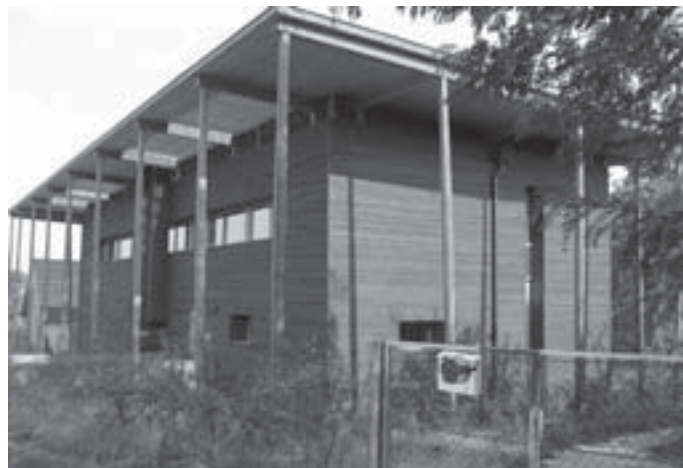
Slika 12: Zahodna fasada hiše S, Böhheimkirchen, Avstrija. Figure 12: Western frontage of the S-house, Böhheimkirchen, Austria.
