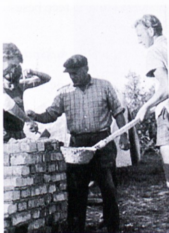
Taborniki in zidarski mojster zidajo kuhinjsko stavbo na Valeti pri Portorožu (1962).
