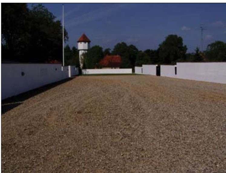
Parkirišče ob cerkvi in vaškem pokopališču, prekrito s peskom, omogoča prepuščanje deževnice v podtalnico (Exner Architekten, Viborg, Danska, 1966–1967).
