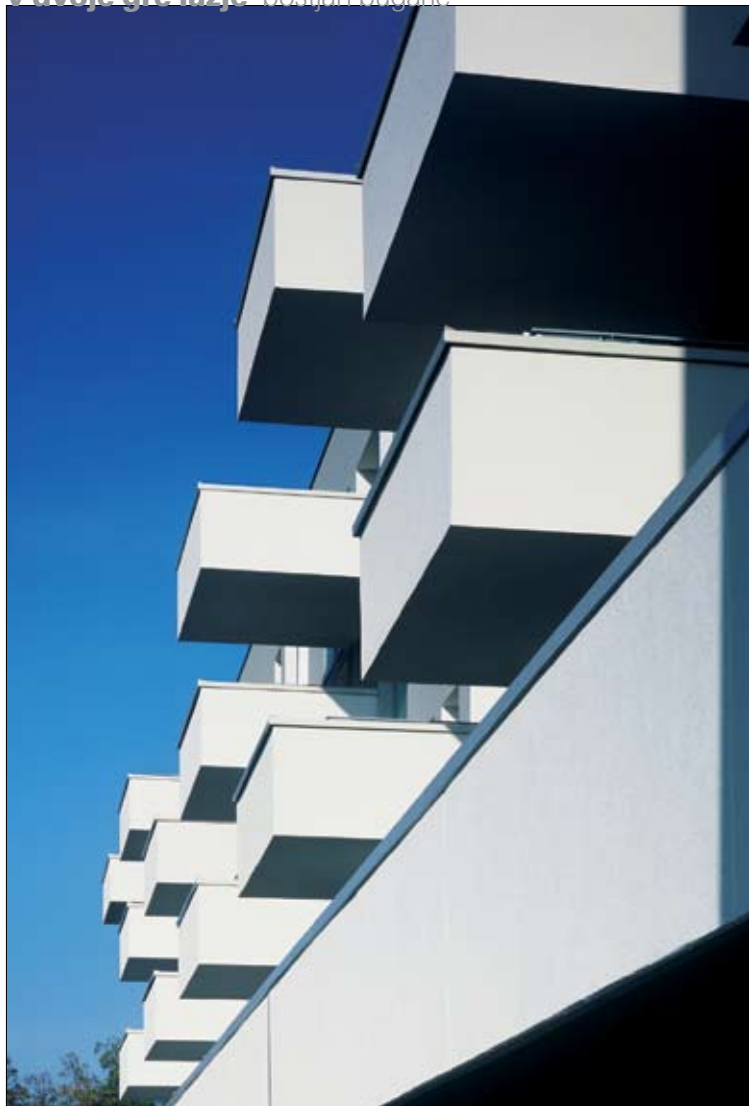
Stanovanjsko-poslovni objekt Glazija (Foto: Miran Kambič)
