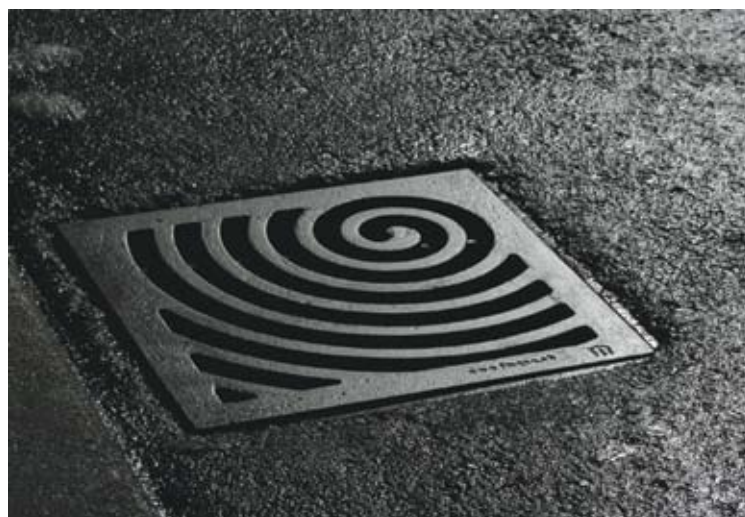
Pokrov kanala za odvodnjavanje meteornih voda je izdelan iz litega železa; funkcionalen, a prijeten na oko. (Oblikovanje: Martino d'Esposito)
