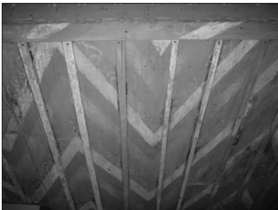
Slika 9: Orgelska empora v cerkvi sv. Ane, izdelana iz ostankov gotskega stropa (foto: Daša Pahor).
