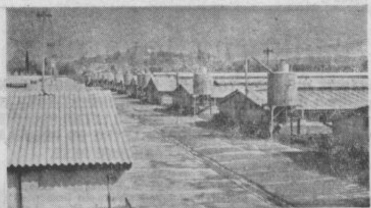
Pogled na novo zgrajene objekte perutninske farme na Bregu
