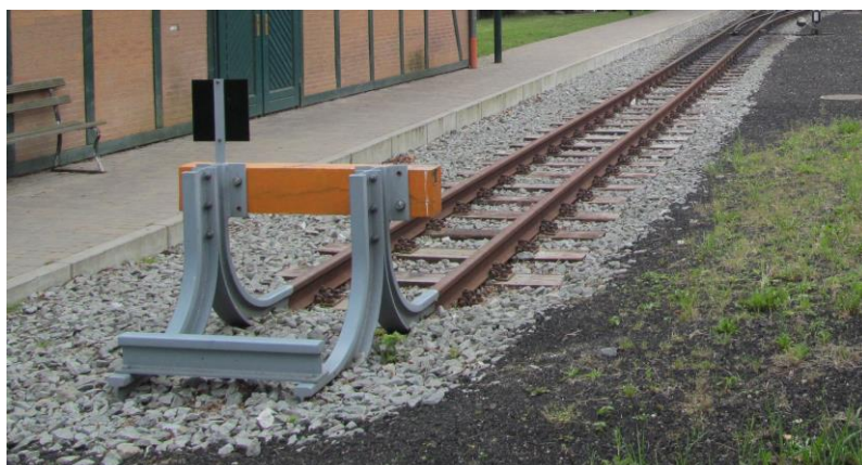
Slika 99: Tirni zaključek na 750 mm ozkotirni progi (Göhren, Rügen, Nemčija)
