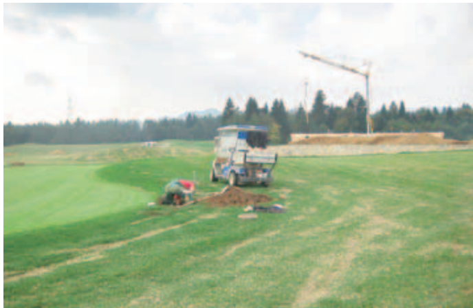
Travnata površina je že skoraj pripravljena.
