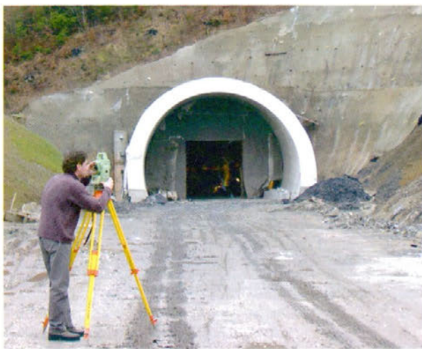
Jamomerci so usmerjali predor (levo), hidrogeologi pa skrbeli za učinkovitejšo in varnejše delo pri gradnji tunela.
