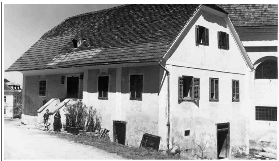
Prva šolska stavba v Šentilju v Slovenskih goricah, zgrajena l. 1787/88. (SŠM, fototeka)
