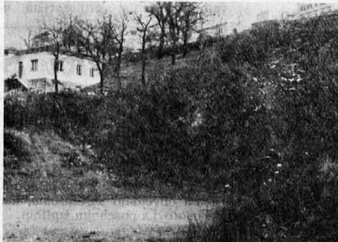
Gradbišče predno so začeli graditi Marijin dom
