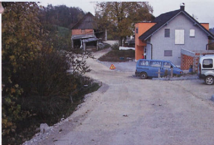
V Žlebeh potekajo dela na odseku Petač-Čarman ...
