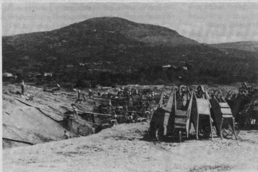
Prilavljalna dela za gradnjo Nove Gorice — regulacija struge potoka Korna, 1948. (Zbirka fotografij o gradnji Nove Gorice. Franc Mervič — Nova Gorica).
