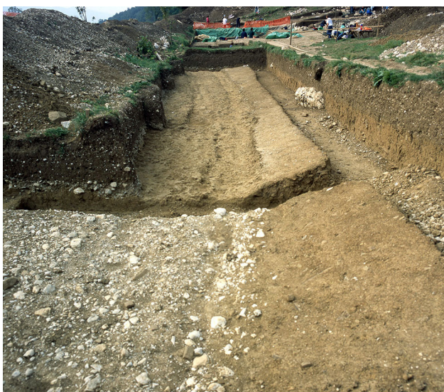
59 Odtis kolesnic v ilovnati podlagi pod cestnim tamponom.
