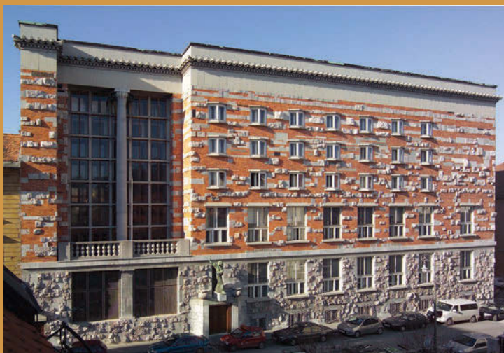
78. Fasada proti Gosposki ulici
