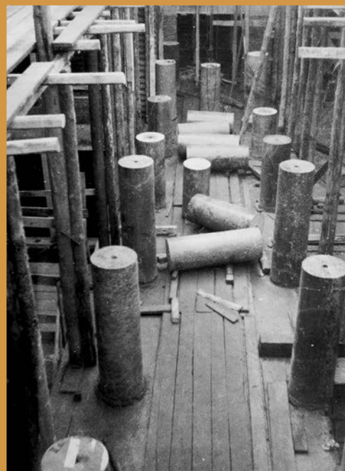
27. Postavljanje stebrov v peristilu stopnišča, 1937
