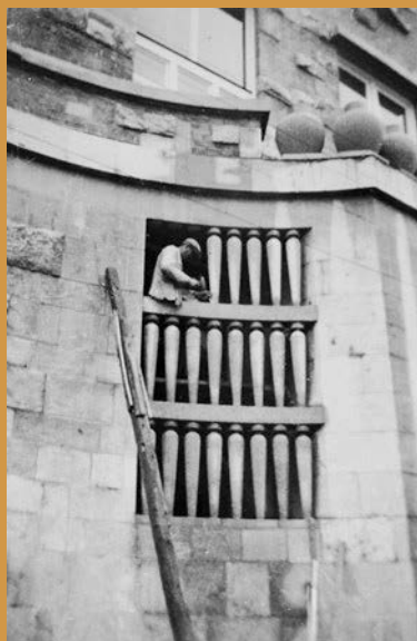
76. Zamenjava betonskih vaz z železnimi mrežami ob vhodu v knjižnico, oktober 1940
