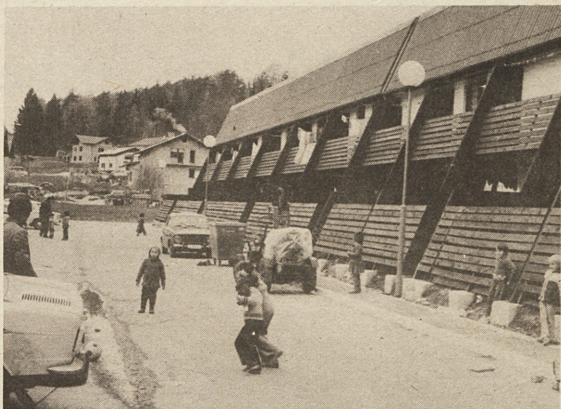
Okna proti soncu in toplotno zaščiten osončna stran — to je vsa umetnost energetske smotrne gradnje. Slika: A. A.
