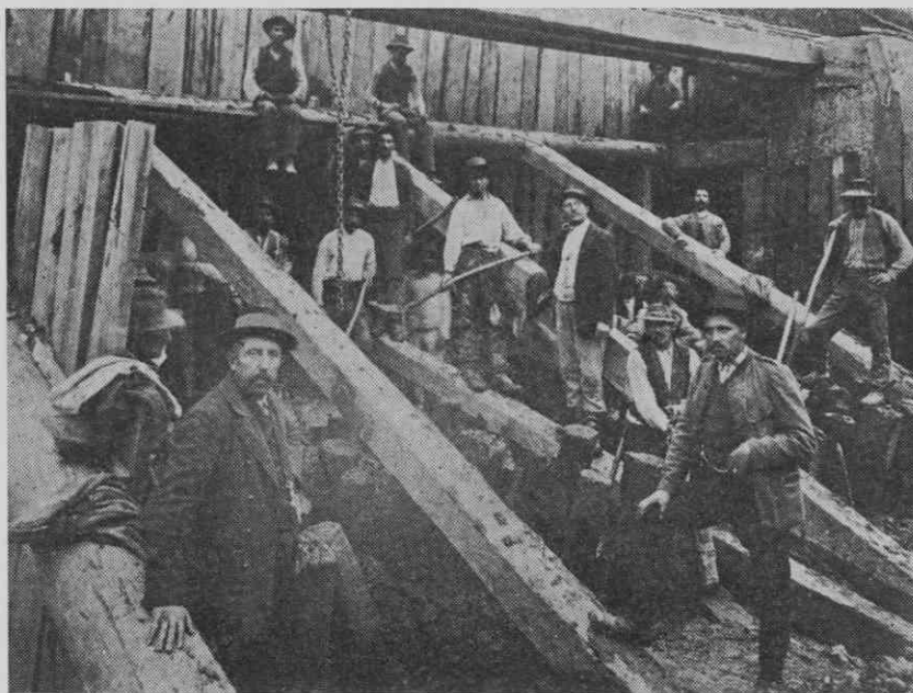
Delavci pri obnavljanju Gruberjevega kanala leta 1910 (fototeka ZAL, Ljubljana)
