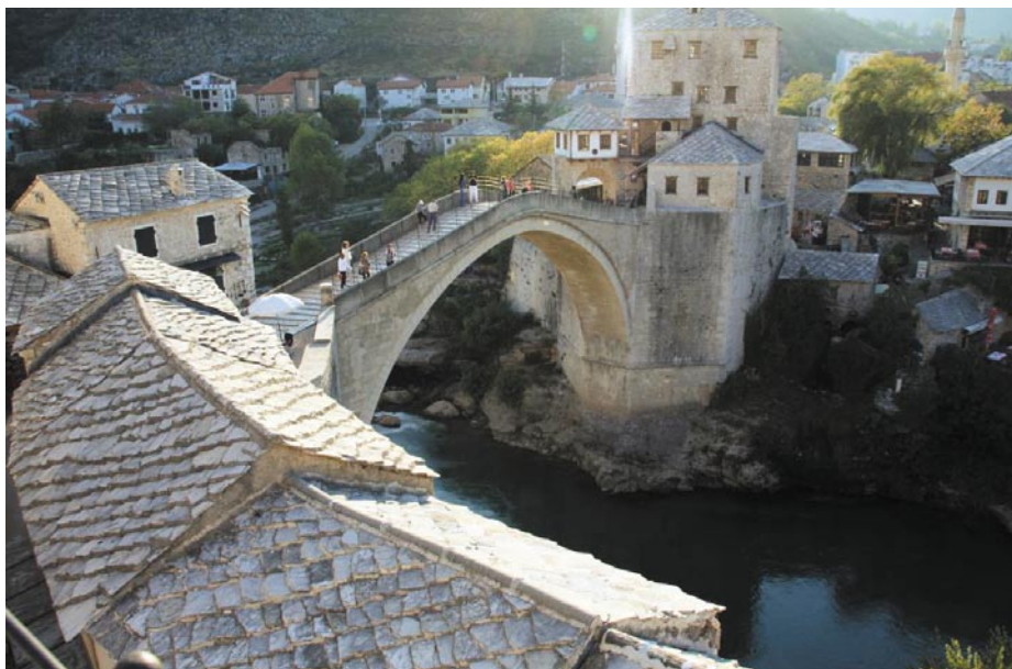
Slika 5 • Most tvori z okolico enkratno, čudovito in arhitektonsko skladno celoto. Razpon nosilnega loka znaša 28,70 metra
