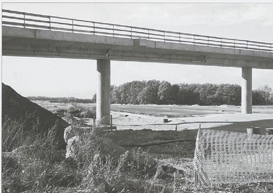
Pogled na traso AC pri Dražencih, kjer je v smeri Zg. Hajdine že položen asfalt.
