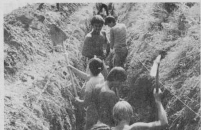
Še zadnji horuk, zadnji metri jarka, zadnja pesem in zadnji brigadirski Z—D—R—A—V—O! Brigadirji ob izkopu jarka v Dolanah.
