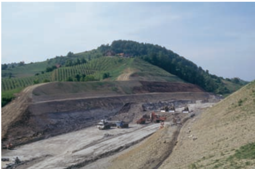
Usek pri Gornjem Štrihovcu tik pred zaključkom zemeljskih del junija 1996. Največ septarij so odkrili na delu, ki sega od električnega droga v obliki črke A do buldožerjev. Velikost septarij se je z globino manjšala. Višina posamezne terase je približno 8 m. Foto: Mirjan Žorž
