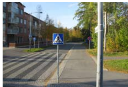
Primer tlakovanega prehoda za pešce.
