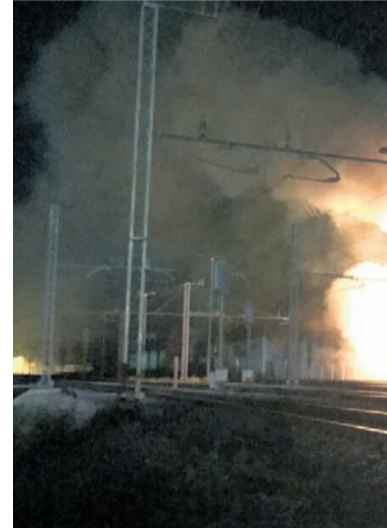
Ogenj na objektu podjetja SŽ VIT je na železniški progi izklopil elektriko, med Pragerskim in Hodošem.
