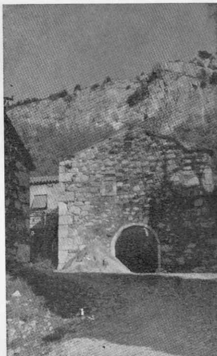
Slika 3. Ruševina baročne stanovanjske hiše
