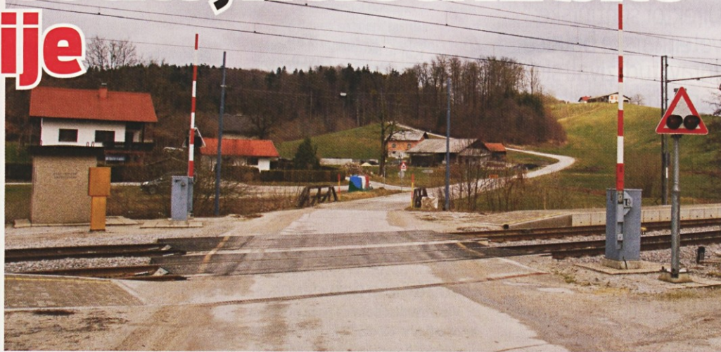
Prehod na Ostrožnem je bil zgrajen pred več kot tridesetimi leti, toda to ne vpliva na raven varnosti, saj je vseskozi redno vzdrževan, trdijo v Slovenskih železnicah.
