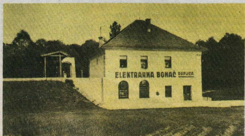
Bonačeva elektrarna na Dupčici, zgrajena v letu 1927, še danes ustvarja električno moč za Papirnico Količevo
