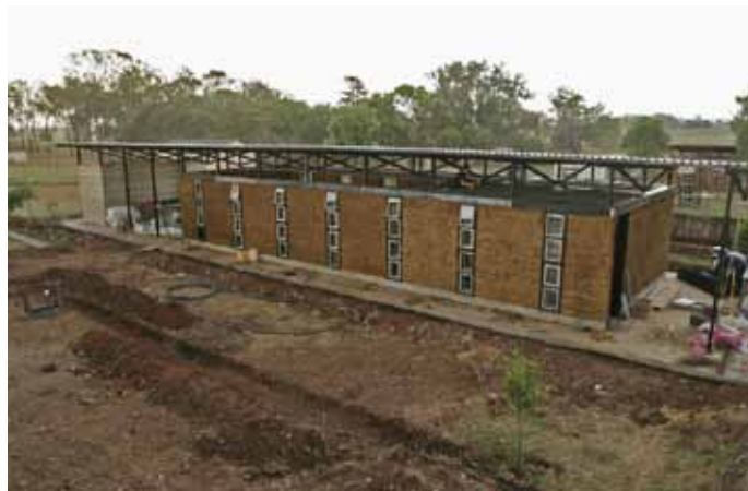
Slika 3: Knjižnica in učilnica, 2010: butanje sten iz mešanice gline in slame.
