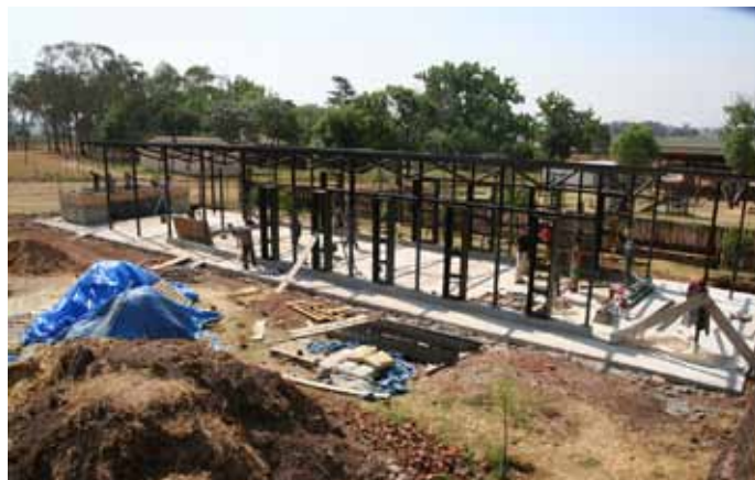
Slika 2: Knjižnica in učilnica, 2010: postavitve jeklene konstrukcije.
