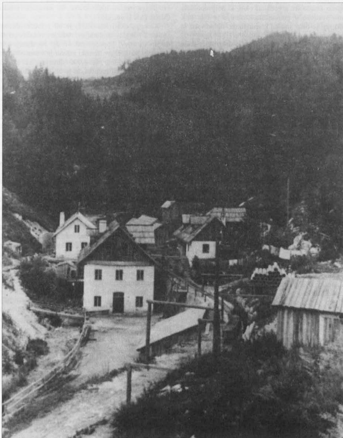
Osrednji rudniški obrat v Heleni, tik pred prvo svetovno vojno. Zidana stavba, levo v ozadju je kovačnica. Original hrani RSC Mežica v zapiranju, d. o. o.
