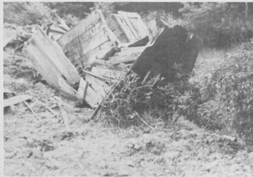
V ta konec Duričeve grabe se življenje ne bo vrnilo. Na sliki ruševina nekdanje Purgove domačije.
