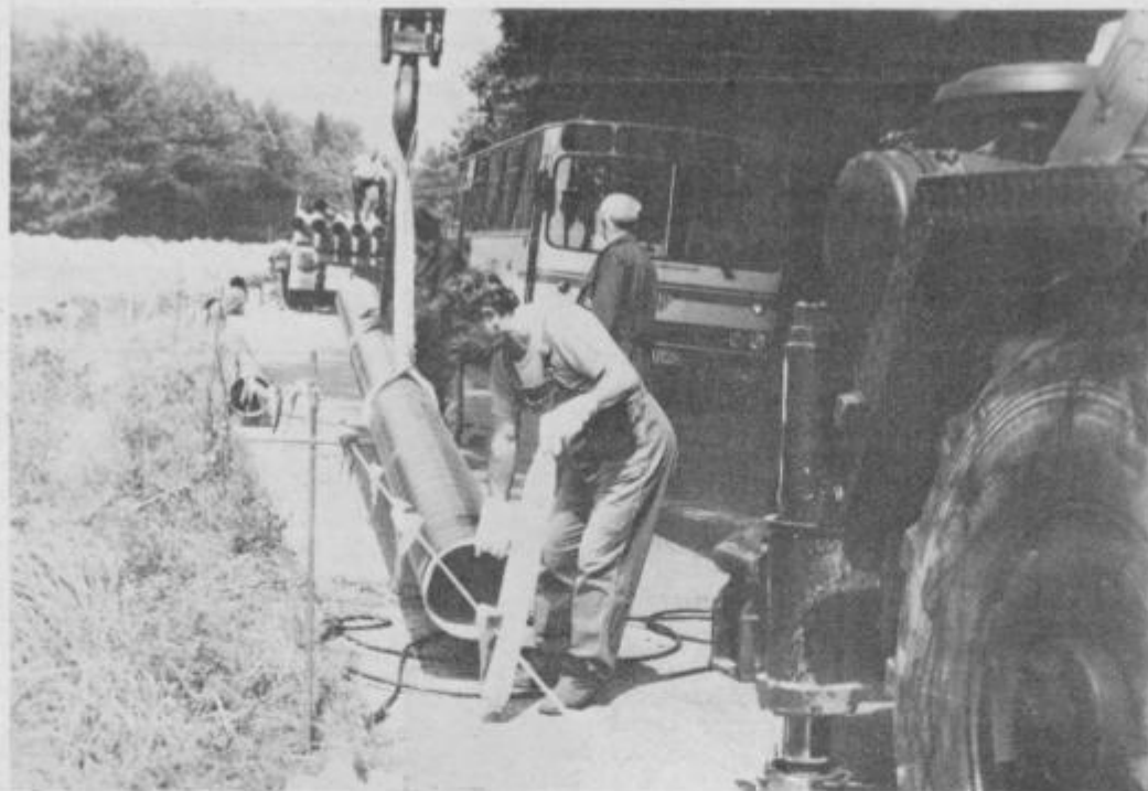
Gradbena dela na trasi nove vodovodne povezave od Skorbe do Dobrovc potekajo pospešeno.
