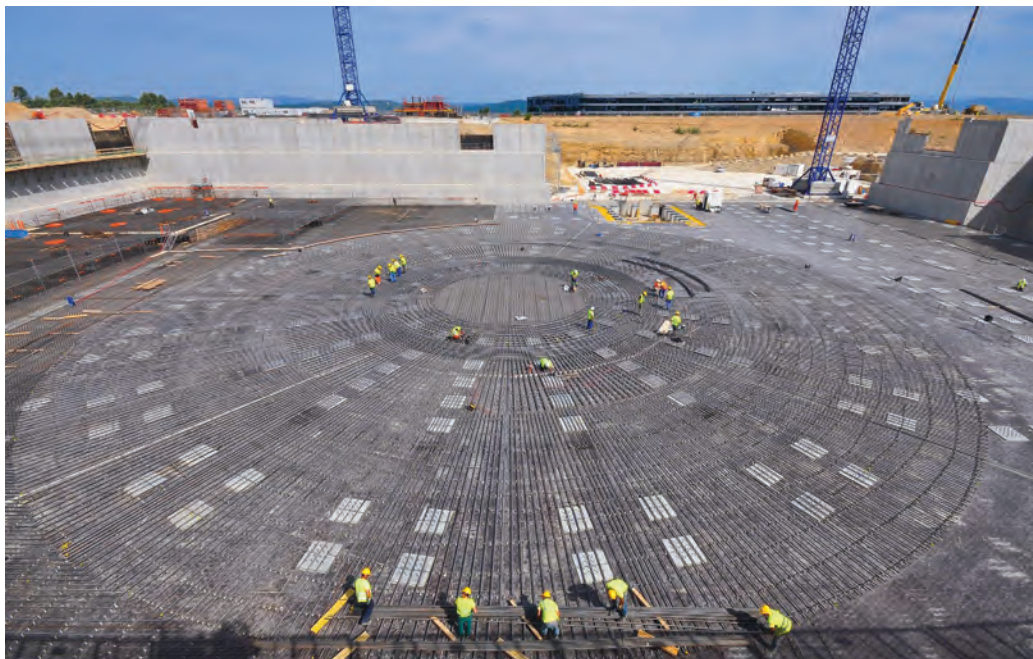
Temelje v Cadarachu so gradili po strogih protipotresnih predpisih.
