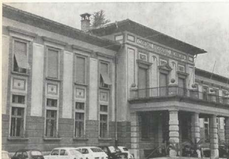
Glavna stavba goriške psihiatrične bolnišnice
