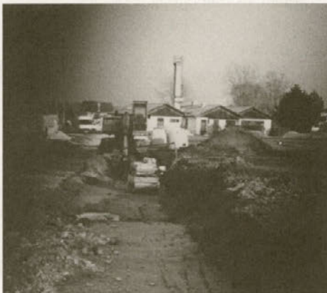
Izgradnja kanala D v novem naselju
