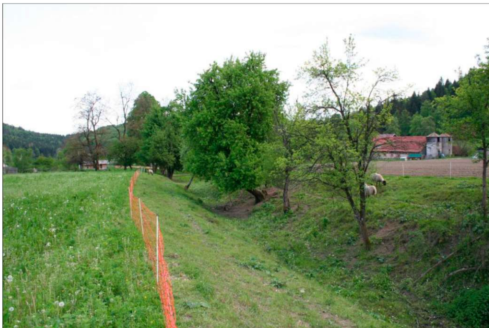
Slika 30: Erozijski jarek v dnu kotanje Nemške loke
