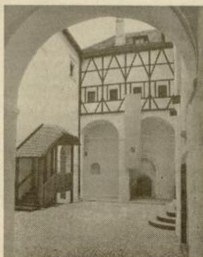
Del obnovljenega grajskega dvorišča in arhitekture.
