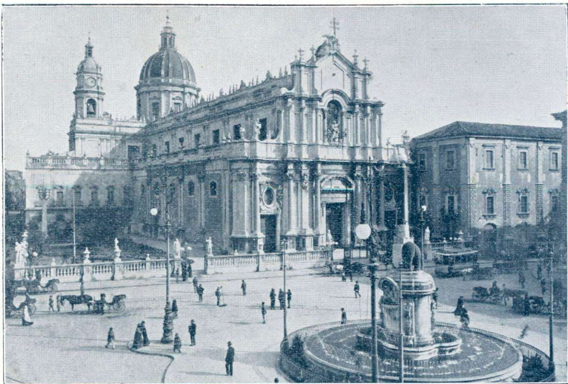
KATEDRALA V KATANII, PORUŠENA OD POTRESA
