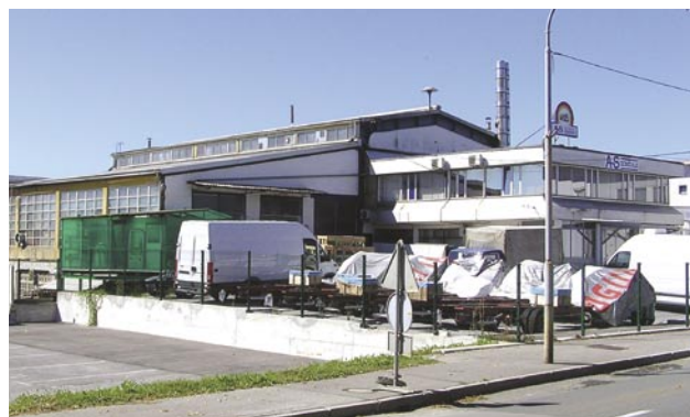
Slika 10: Nadgradnja motornih vozil v Avtoservisu ob vstopu v Domžale iz smeri Trzina. Doživljajsko zmožnost območja zmanjšujejo stara poslopja, potrebna prenove, in odpadni avtobusi ali njihovi deli na nasprotni strani tovarne (foto: Simon Kušar).
