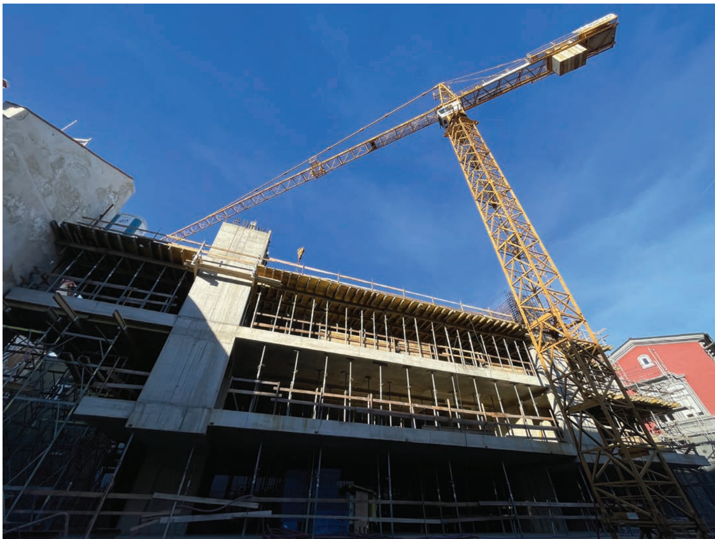
Slika 2. Gradbena dela na novi Mariborski knjižnici (25. 11. 2024).
