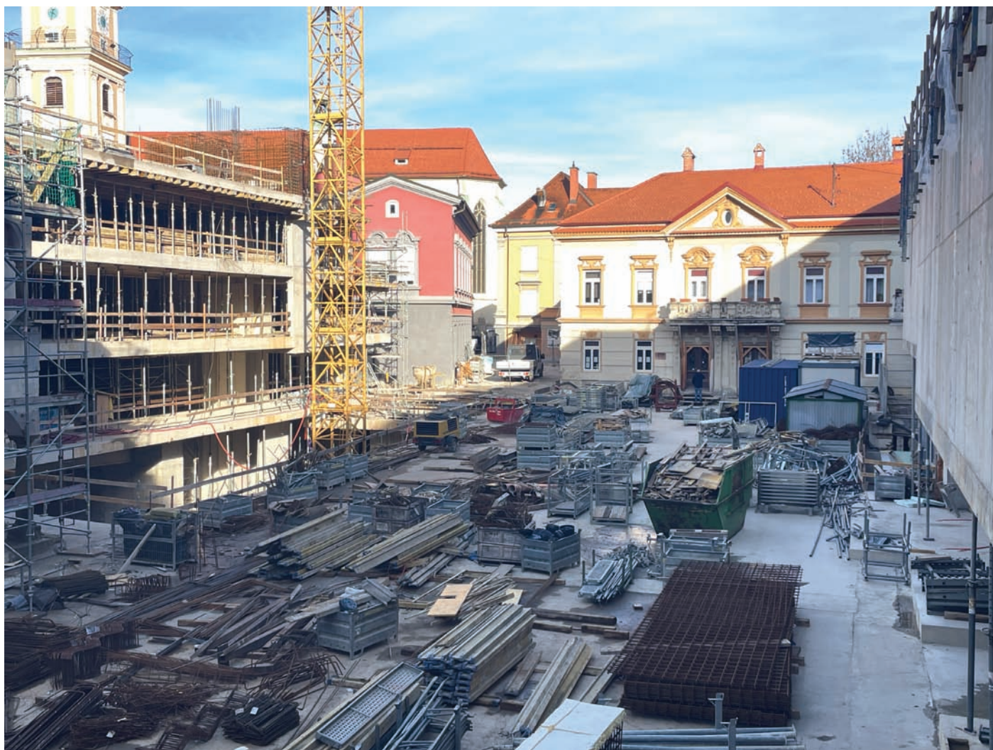
Slika 1. Pogled na gradbišče Centra Rotovž (25. 11. 2024).
