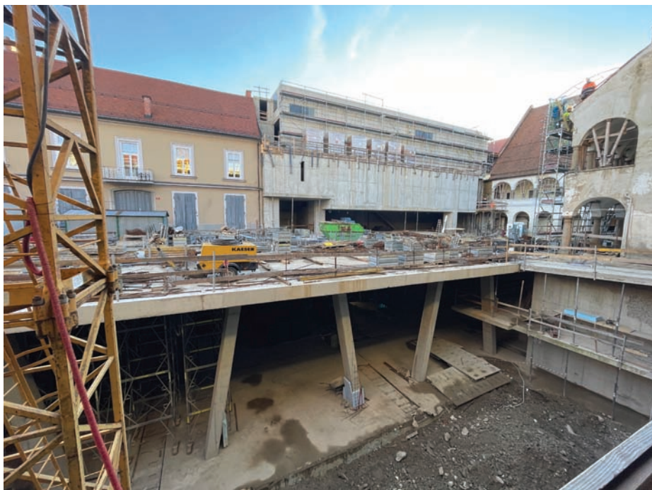
Slika 3. Gradnja bodočih prostorov Umetnostne galerije Maribor (25. 11. 2024).
