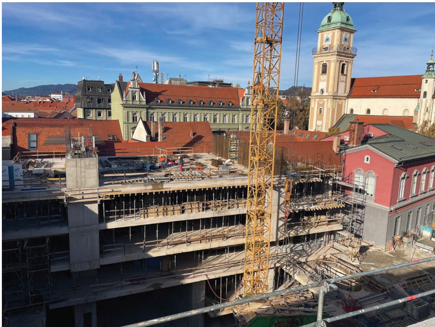
Slika 8. Pogled na gradbišče s strehe Umetnostne galerije Maribor (25. 11. 2024).
