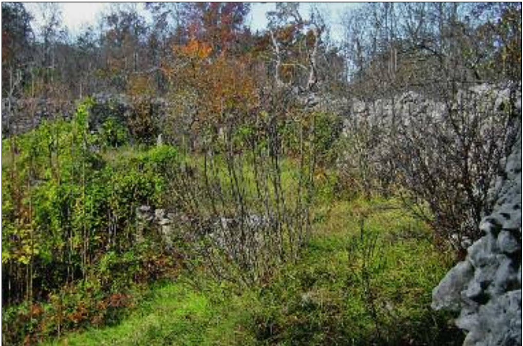
Slika 6: Na že davno opuščeno njivo na Krasu spominja le še podporni zid, ki je bil obenem zunanji rob kmetijske terase. Ta se je že po nekaj metrih končala z visokim zidom otrebljenega kamenja.
