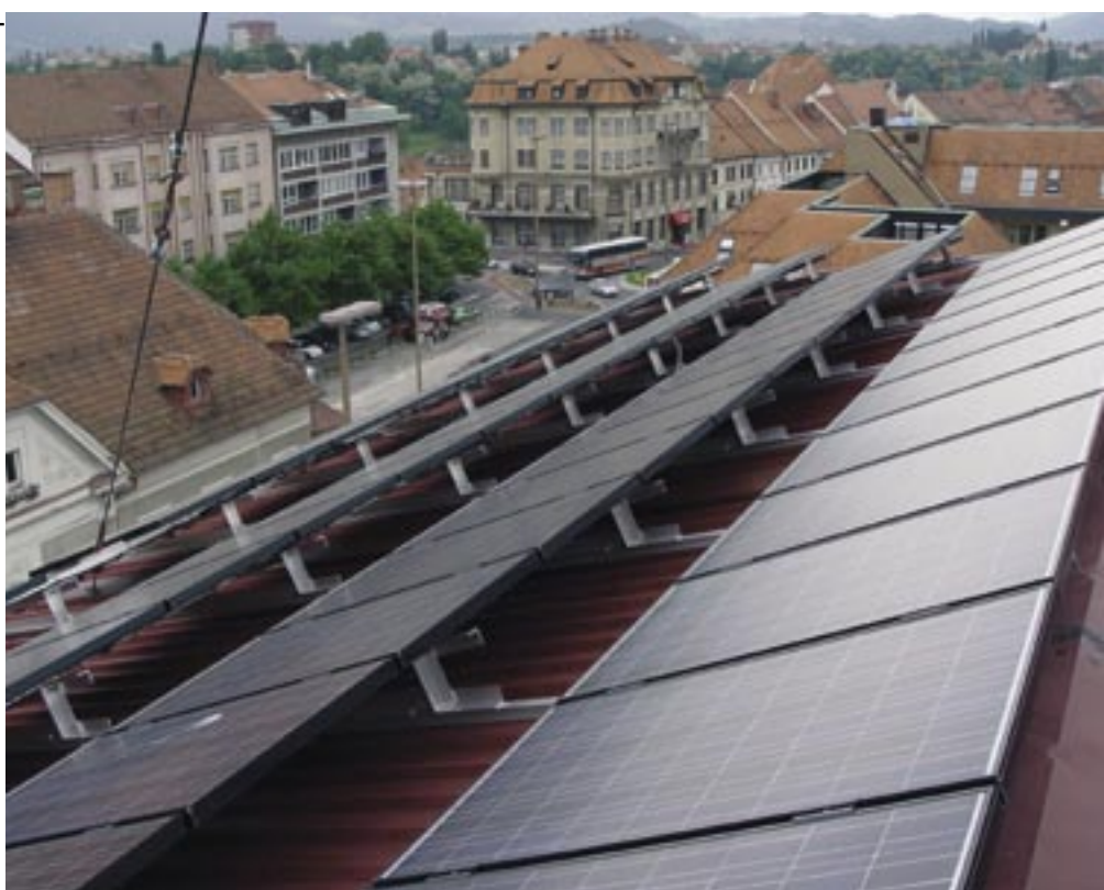
Novi videz strehe poslovne stavbe Elektro Maribor.
