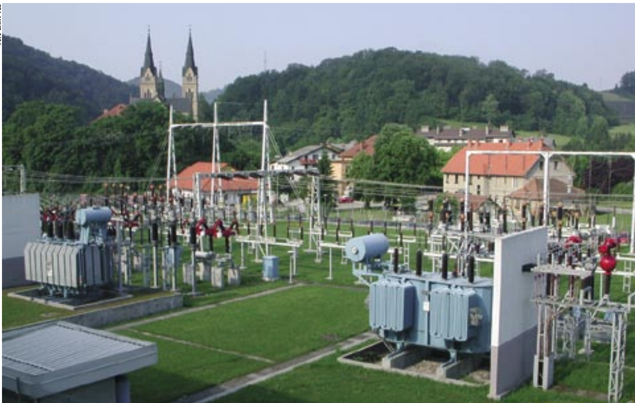
Obstoječe prostozračno stikališče 110/20kV v TEB.
