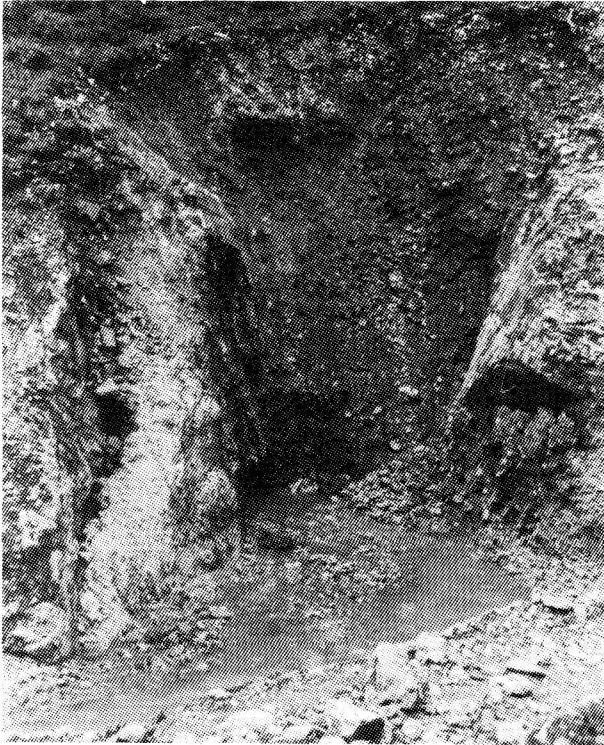
Sl. 4: Izvir Kajža II med gradnjo zajetja. Voda priteka iz zasutega kraškega rova ob robu 3 do 4 m široke pretrte cone v spodnjekrednem apnencu. Foto: Jože Janež
