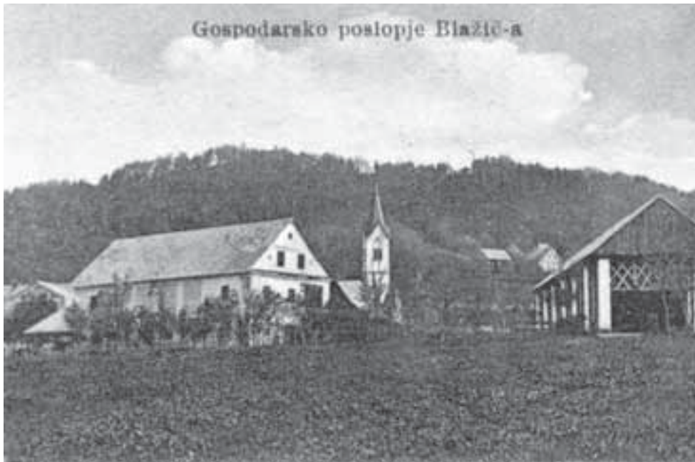
Županov hlev in kozolec pred 1. svetovno vojno, detajl razglednice, našel Franc Temelj
