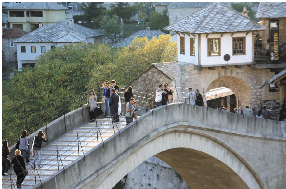
Slika 4 • Pohodna površina mostu je razmeroma strma in je pokrita s kamnitimi ploščami ter prečnimi rebri proti zdrsu
