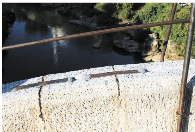
Slika 2 • Replika vezi med posameznimi deli kamnite ograje mostu. Turški graditelji mostu so vse železne vezi med kamni zalili s svincem
