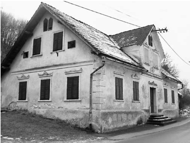
Leta 1898 so na mestu prejšnje zgradili gostilno z velikim gostilniškim prostorom in prenočišči za furmane. Foto: Valentin Skubic, Višnja Gora, 2011
